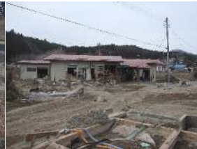
下流家屋の被害
