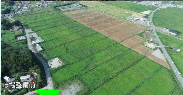
津波による被災状況
