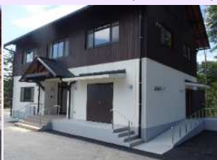
ダム管理棟の新設
