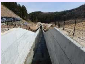
洪水吐の断面拡大
