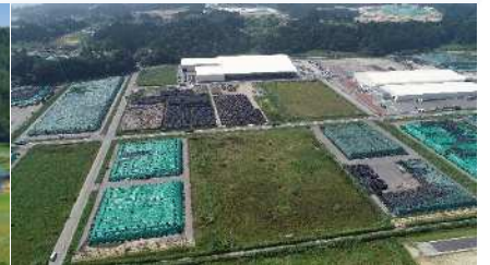
中間貯蔵施設に運ばれた除染土
