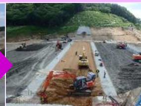
H28.6 本堤盛土状況
