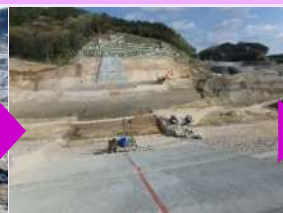
H27.5 本堤掘削完了
