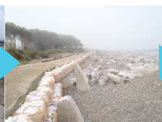
応急工事（仮締切（大型土嚢））
