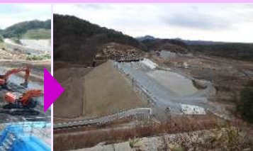
H28.12 本堤盛土完了
