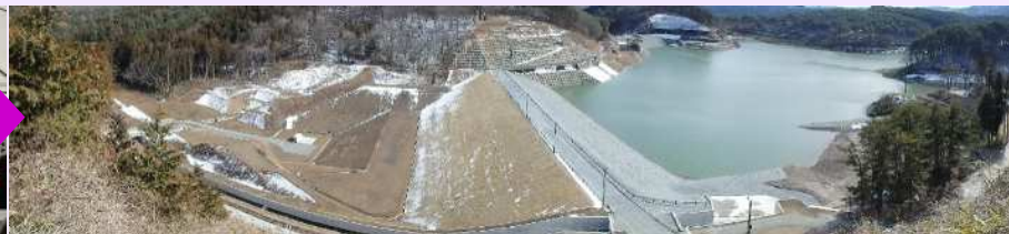
H29.3 湛水試験状況
