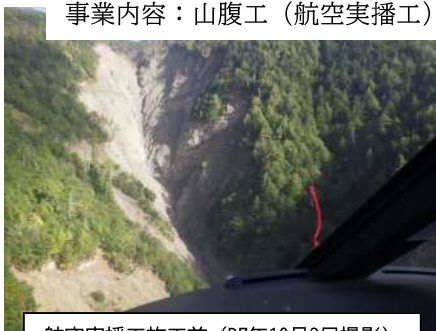
航空実播工施工前（R7年10月2日撮影）
